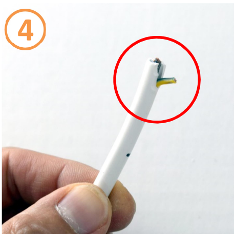
Витягніть 1 дрід плоскогубцями до мітки на зовнішній ізоляції.
